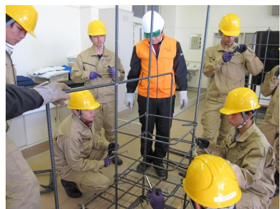
技術者による実践的指導 (鉄筋工)
