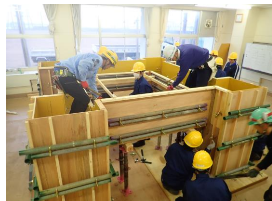
技術者による実践的指導 (型枠大工)
